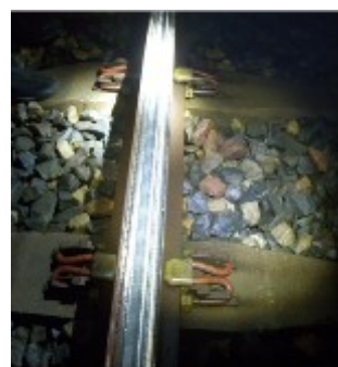
rail après meulage
